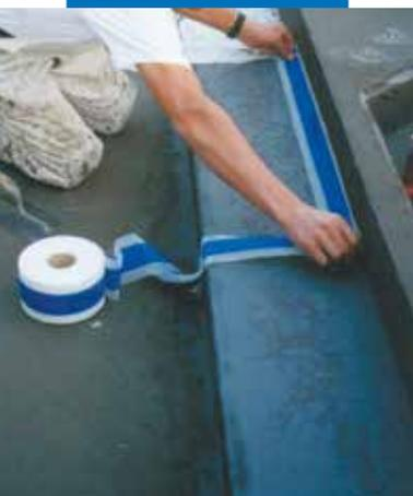
Exemple d'imperméabilisation avec Mapeband de l'angle entre le fond et la partie d'une baignoire
