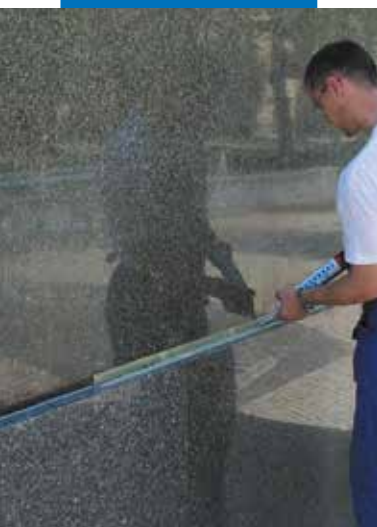
Jointoiment d'un joint de façade avec Mapesil LM
