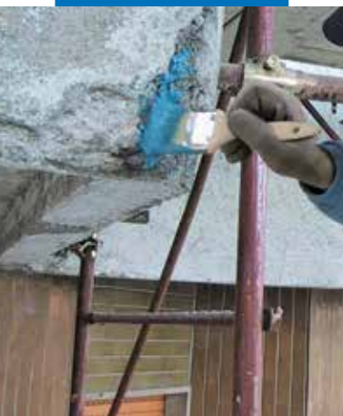
Application au pinceau de Mapefer 1K sur des armatures de balcon en béton armé
