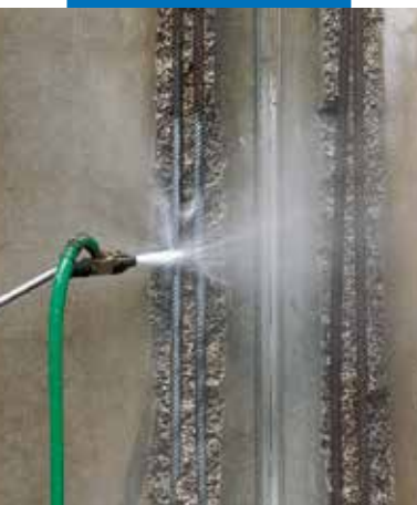
Décapage des fers par hydrosablage
