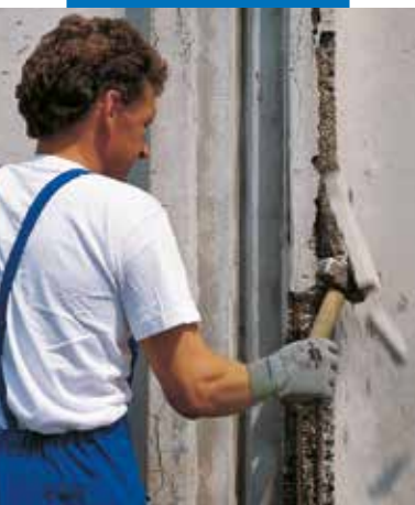
Démolition du béton dégradé
