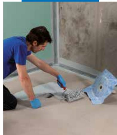
Application d'un drain vertical avec **Mapegum WPS**
