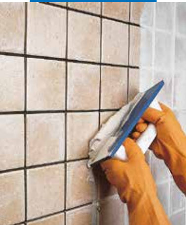
Jointoiement d'une paroi de grès étiré avec une spatule en caoutchouc
