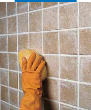
Finition d'un mur de grès étiré avec une éponge
