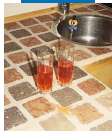
Exemple de collage et de jointoiment d'un plan de travail de cuisine
