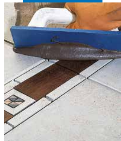
Jointoiment, à la spatule, de carrelage céramique avec insertion de bois
