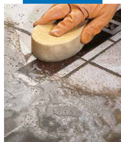
Finition à l'éponge, de carrelage céramique avec insertion de bois
