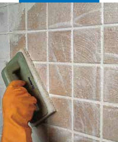
Finition d'une paroi de grès étiré avec un tampon Scotch-Brite®
