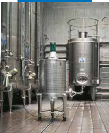
Exemple de jointoiment dans une cave vinicole
