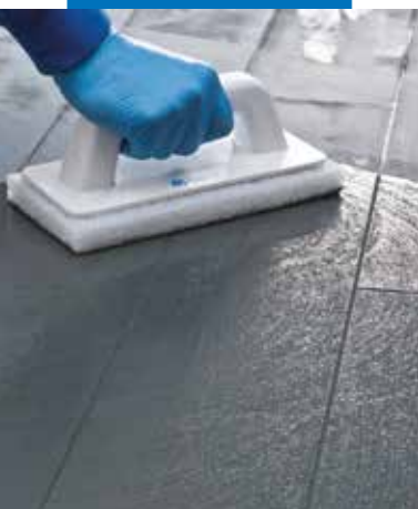
Nettoyage des joints avec un pad Scotch-Brite® (quand le produit est partiellement durci)
