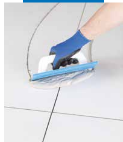
Application d' Ultracolor Plus sur un sol carrelé en grès cérame avec une spatule en caoutchouc pour joints
