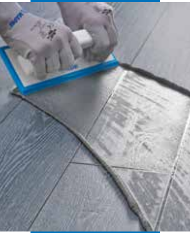
Application d'Ultracolor Plus sur un sol carrelé en grès cérame effet bois avec une spatule en caoutchouc pour joints
