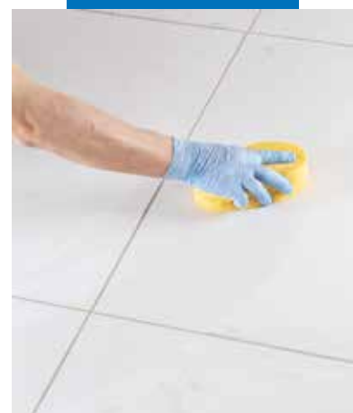
Nettoyage et finition des joints avec une éponge en cellulose dure
